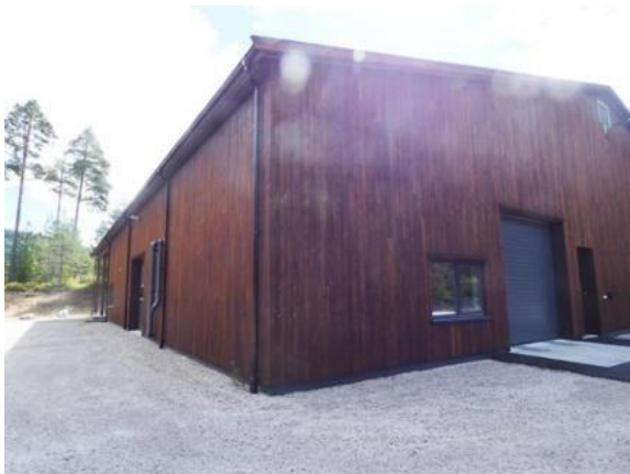
Figur 32 Bygg for avløpsrenseanlegg for Bygland
