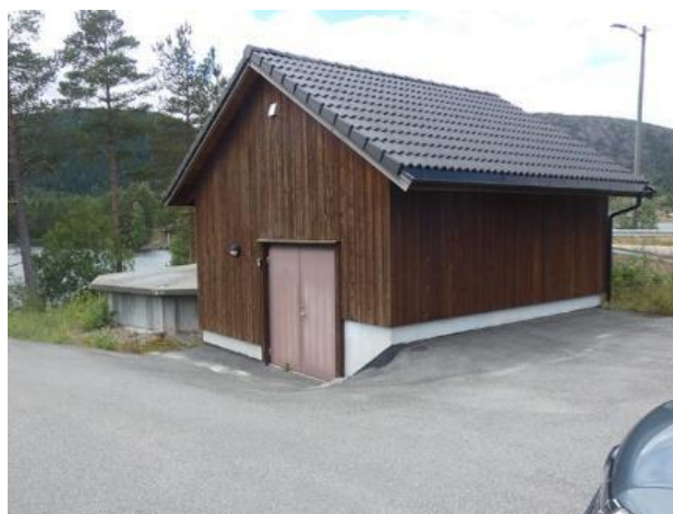
Figur 40 Biologisk forbehandling av avløpsvann fra tine Meierier før påslipp til offentlig avløp
