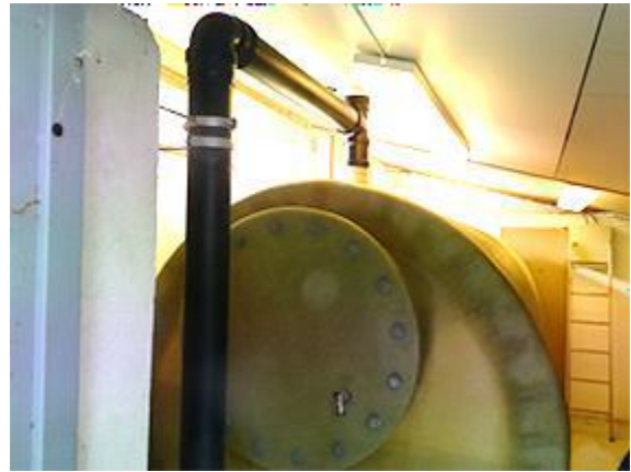
Figur 20 Høydebasseng, glassfibertank
