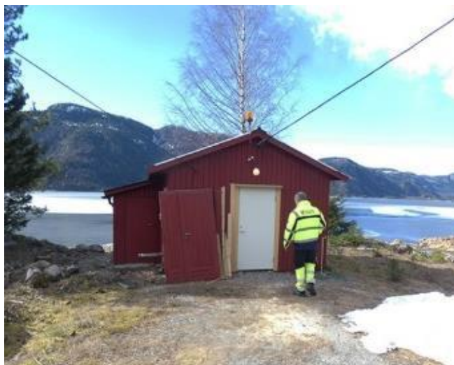
Figur 8 Vannverket på Åraksbø
