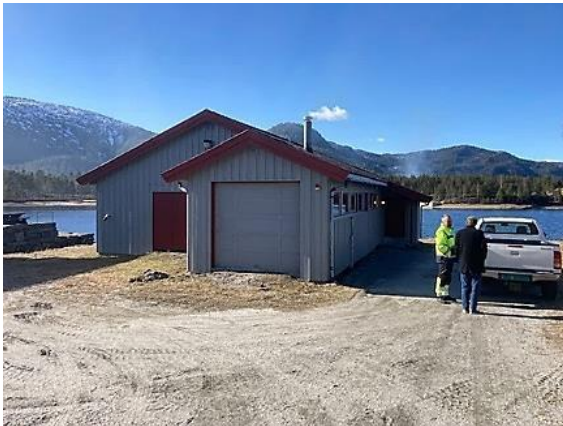
Figur 22 Vannverket ved Byglandsfjord
