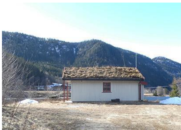
Figur 6 Vannbehandlingsanlegget på Ose
