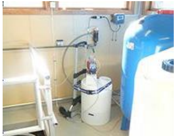
Figur 25 Klordoseringsutstyr
