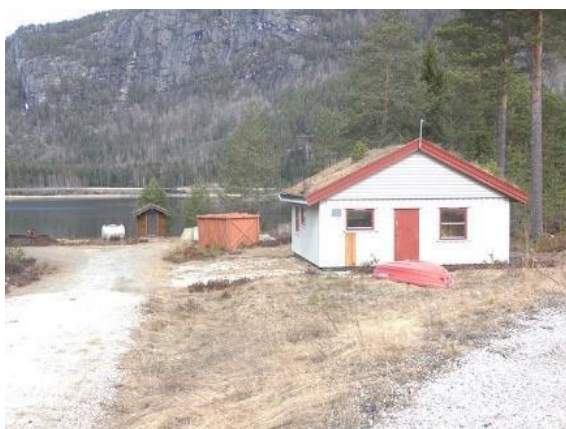
Figur 14 Bygland vannverk med inntakspumpestasjon i bakgrunnen.
