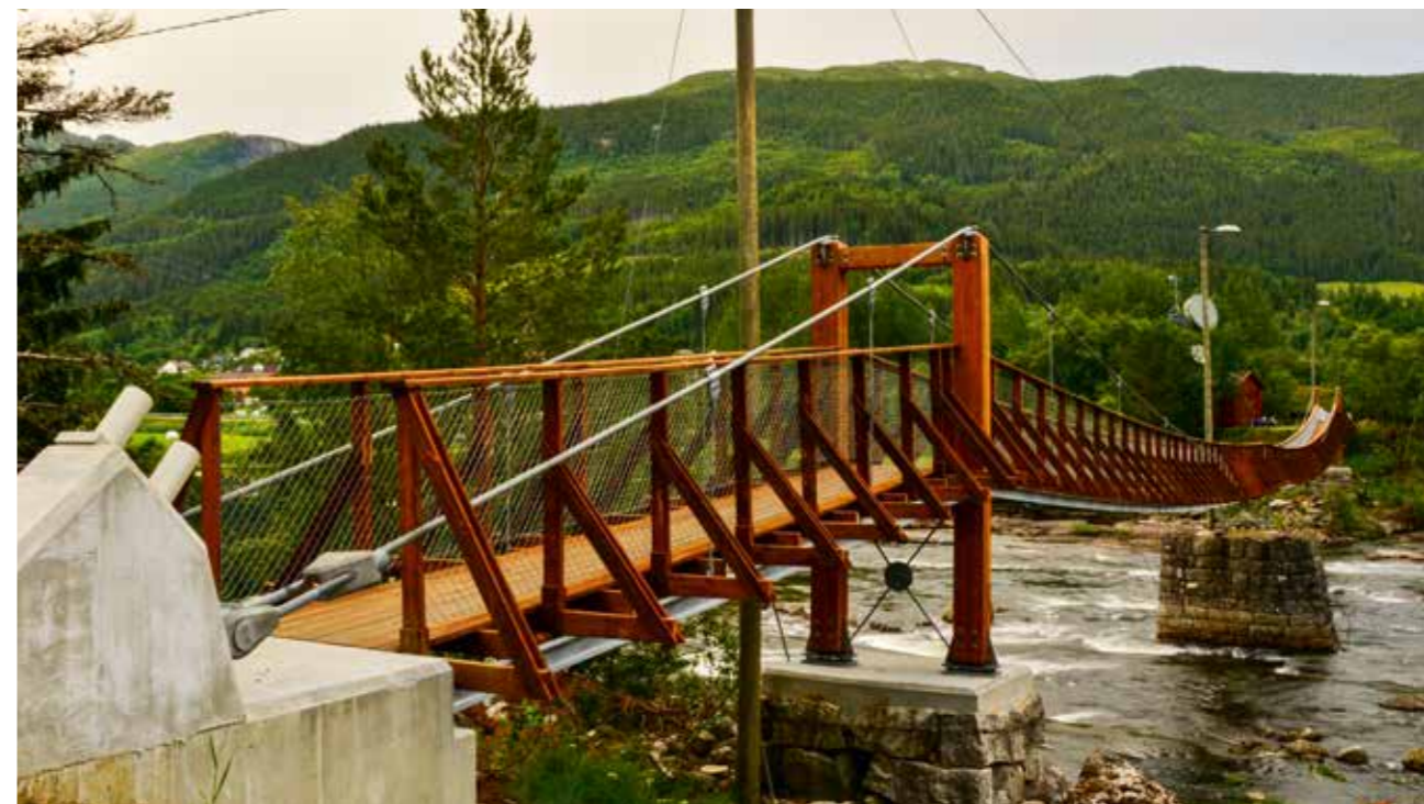
Prestefossen hengebru mellom Valle sentrum og Nomeland. Foto: Geir Daasvatn.
