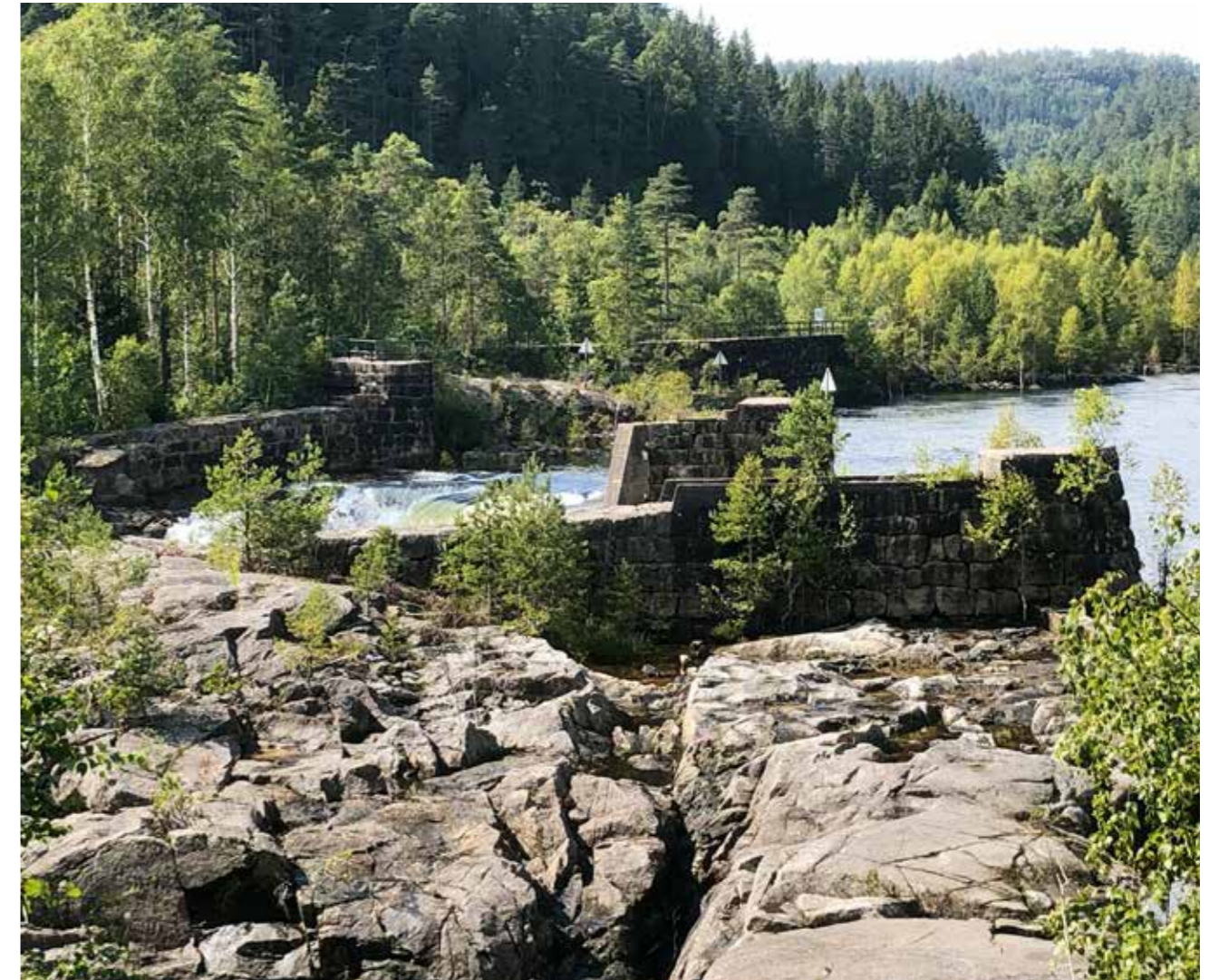
Kringsjådammen er en nåledam, mer enn 100 meter lang og 8,5 meter på det høyeste. Foto: Tom Egerhei, 2020
