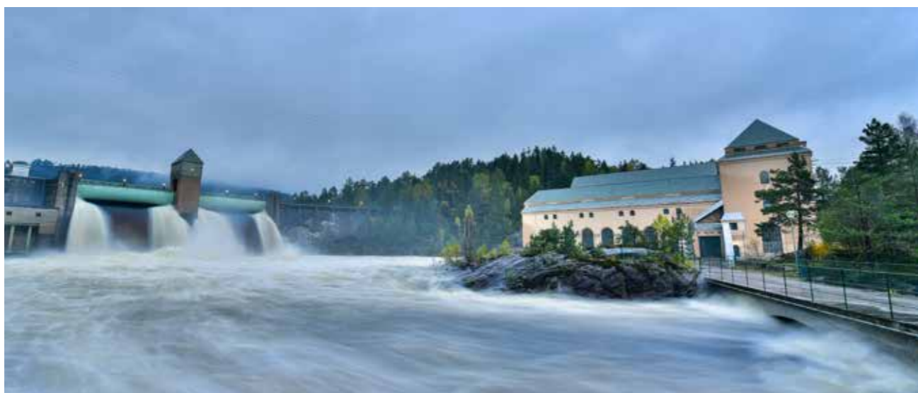
Nomeland kraftstasjon i Iveland. Foto: Geir Daasvatn
