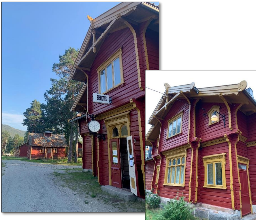
Stasjonsbygningen Bileta viser stasjonen frå sida mot perrongen (med ur) og mot hagen.
