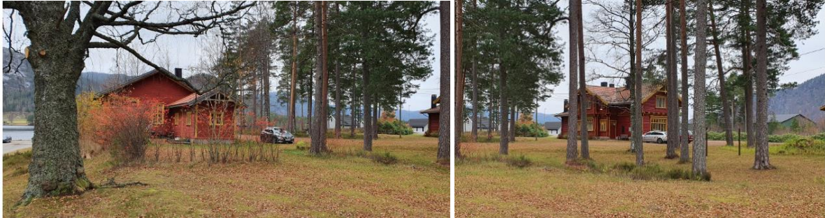
Byglandsfjord stasjon og litt av uteområdet, november 2020. Foto: Agder fylkeskommune
