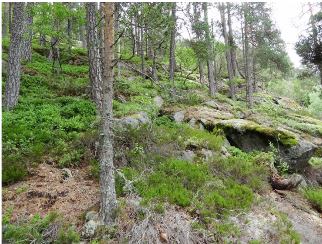
Figur 3. Fjellkvalitet i svaene bak bolighusene i område A26. Berget er lite oppsprukket og generelt stabilt.
